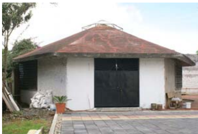
Das Schulgebäude Santissima Trinidad stellt die Katholische Kirche kostenlos zur Verfügung.
